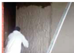
Foto 3 Aplicación de yeso por chicleo
