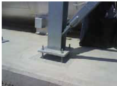
• Imagen 2. Grouting a nivel
