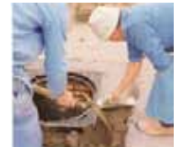
Foto 6. Relleno con ADICRET Reparación ARI.
