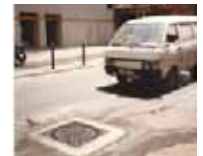
Foto 7. Puesta en tránsito.
