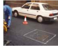
Foto 1. Área de reparación.
