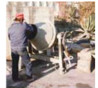
Foto 4. Mezclado de ADICRET Reparación ARI.
