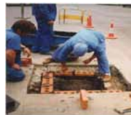
Foto 5. Enladrillado de base.
