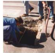
Foto 3. Limpieza y cubicación.
