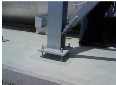
Imagen 2. Grouting a nivel
